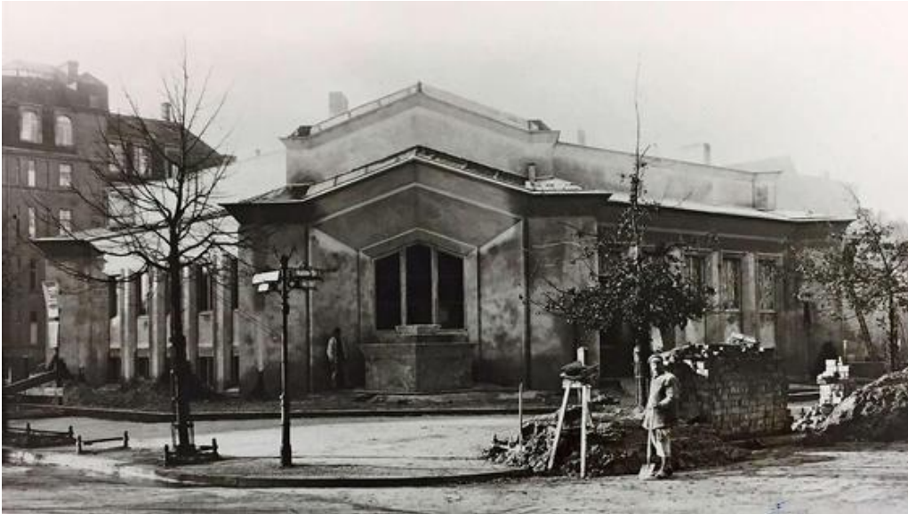
1922. In Berlin-Westend lassen sich die Buchthals eine expressive Villa bauen. Die Baustelle ist auf diesem Foto festgehalten. Foto: Lenzwerk
