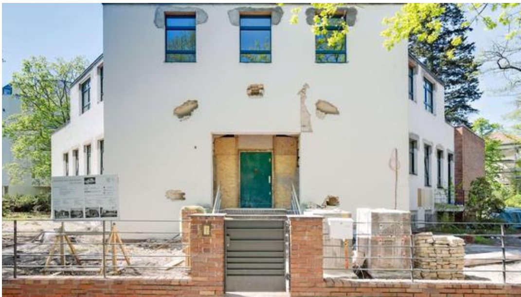
2015. Die Sanierung wird begonnen. Sie versucht einen Kompromiss aus Original und Umbau. Foto: Lenzwerk
